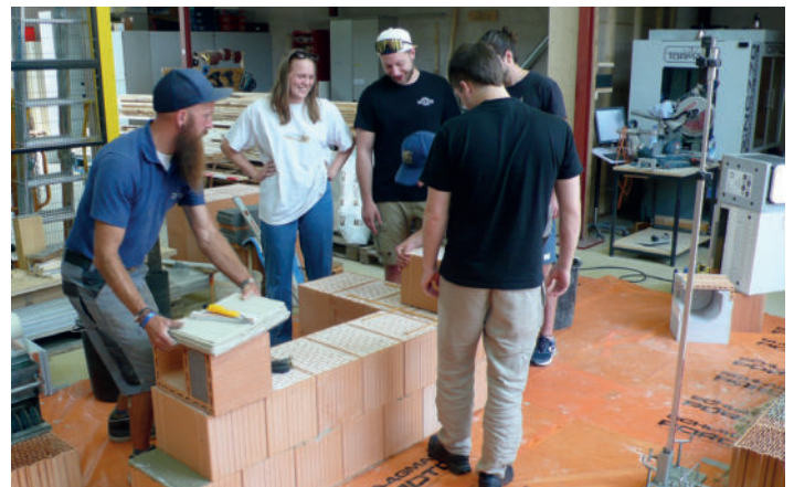
Erstellung von Mauerwerk aus hoch wärmedämmenden Mauerziegeln mit verschiedenen Klebesystemen
