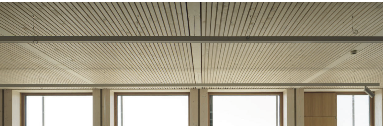
Holz-Beton-Decke mit eingelegten Schall absorbierenden Holzfaserstreifen
