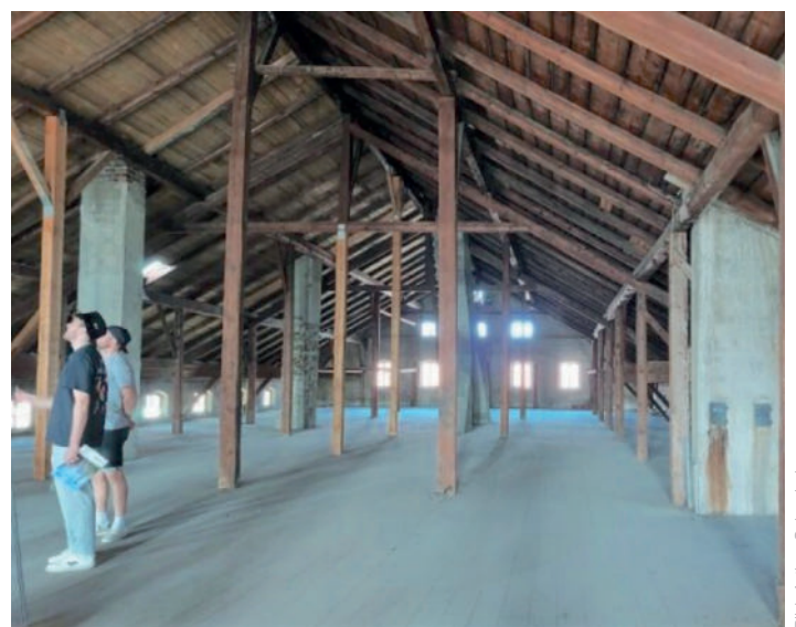
Besichtigung des Dachstuhls
