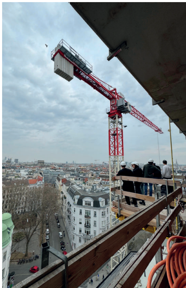
Auf der Baustelle des Athlan Quartiers
